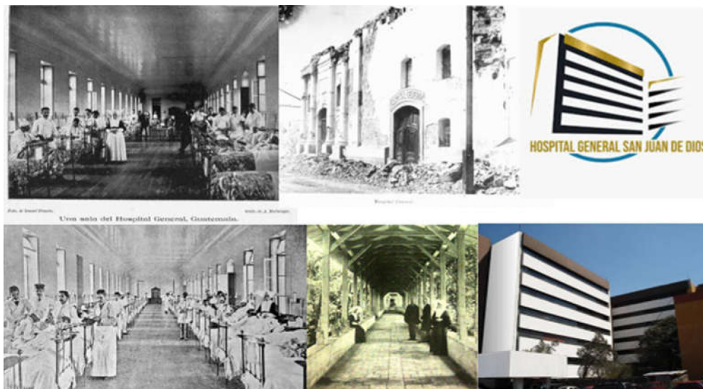
Figura 4. El hospital general San Juan de Dios y el edificio moderno actual que se construyó después del terremoto de 1976.
