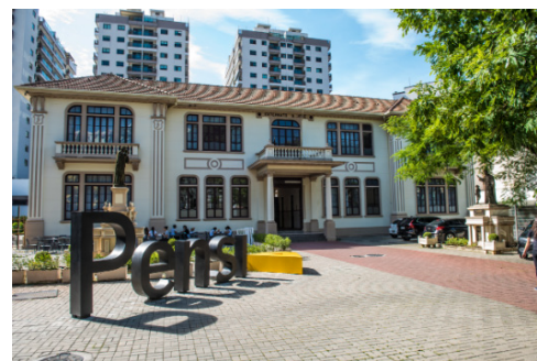
Figura 4 Fachada del edificio catalogado del Colégio Marista São José, dirección actual del Colégio Pensi (Calle Barão de Mesquita, número 164).
